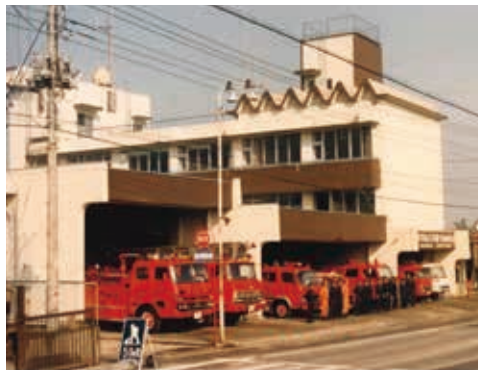
三輪野山 110 番地の 1 に竣工した消防本部・消防署庁舎
