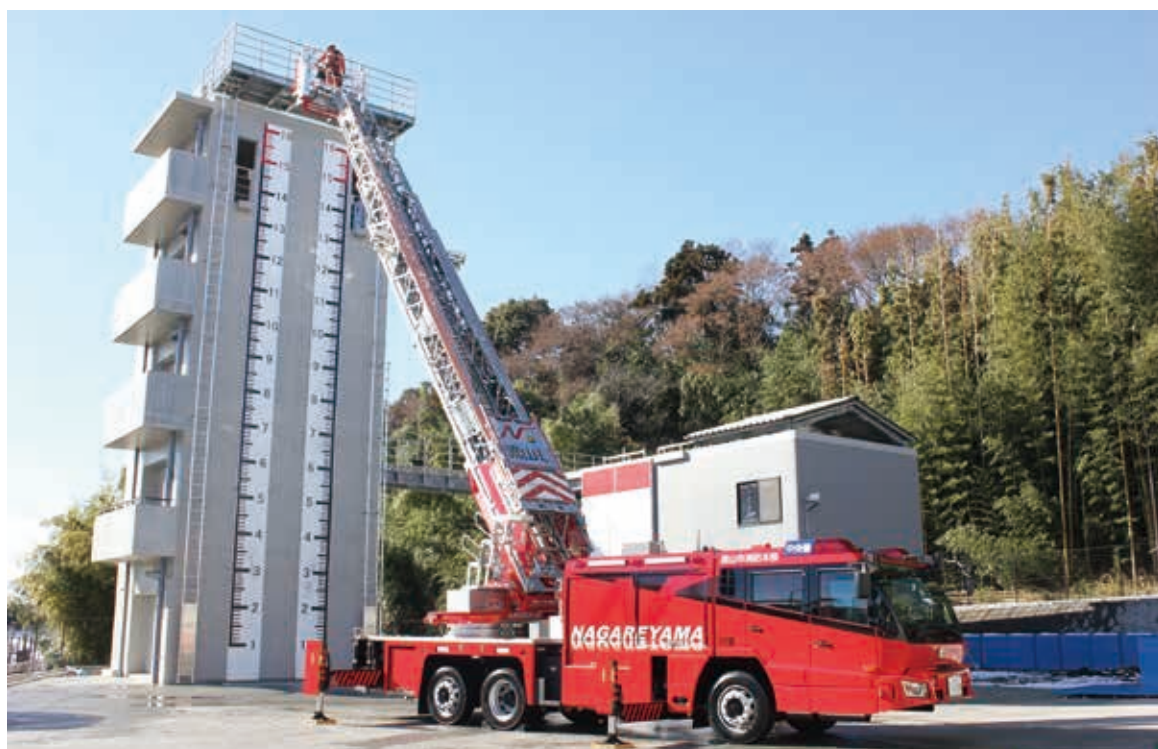
流山市消防本部 中央消防署・消防訓練塔
