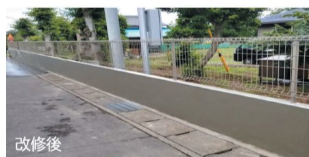
コンクリートブロック塀の改修例
