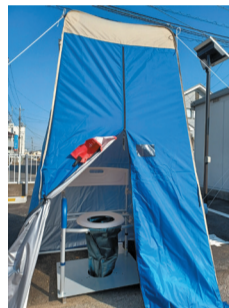
北部公民館のマンホールトイレ
