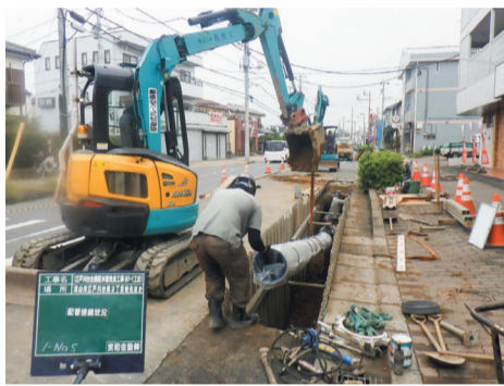
配水管改修の様子
