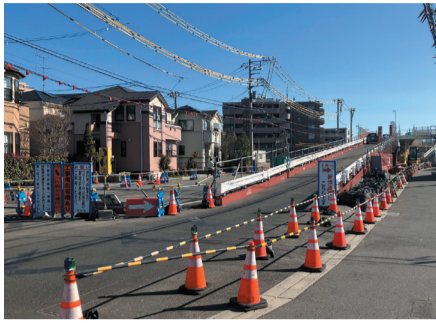
拡幅工事が進む名都借跨線橋
