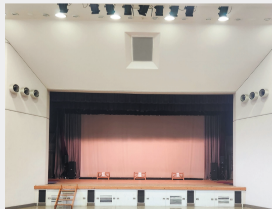
改修予定の多目的ホール
