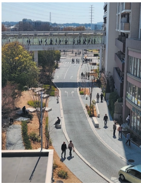
整備が完了した区域
