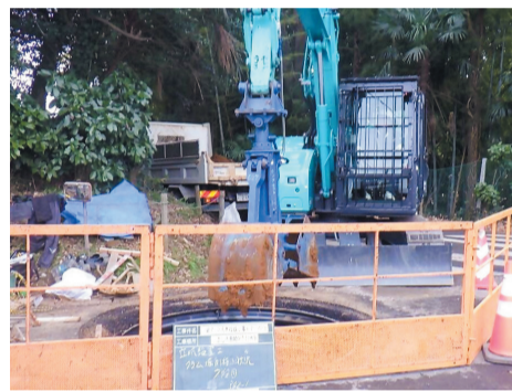
下水道整備の様子
