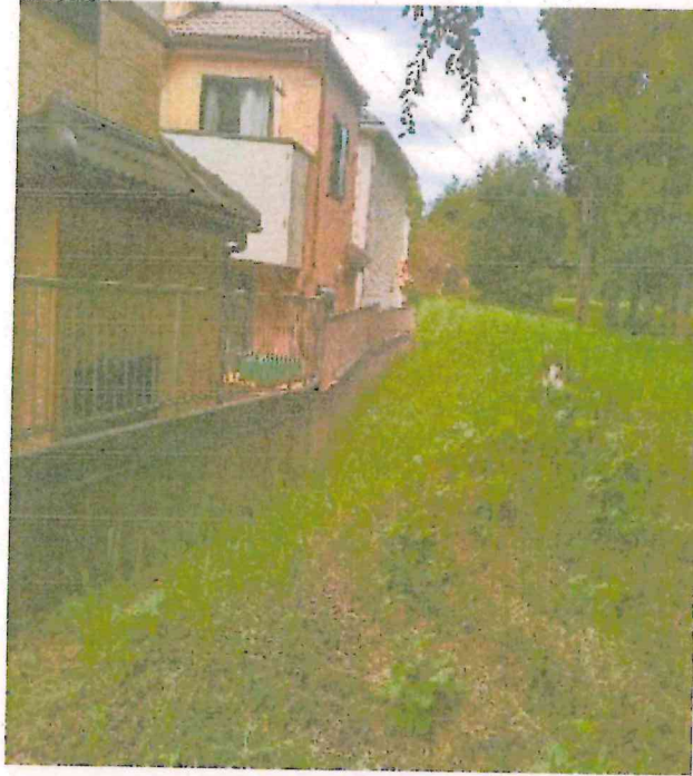
写真⑥:擁壁の高さは1階の半分程度ある
