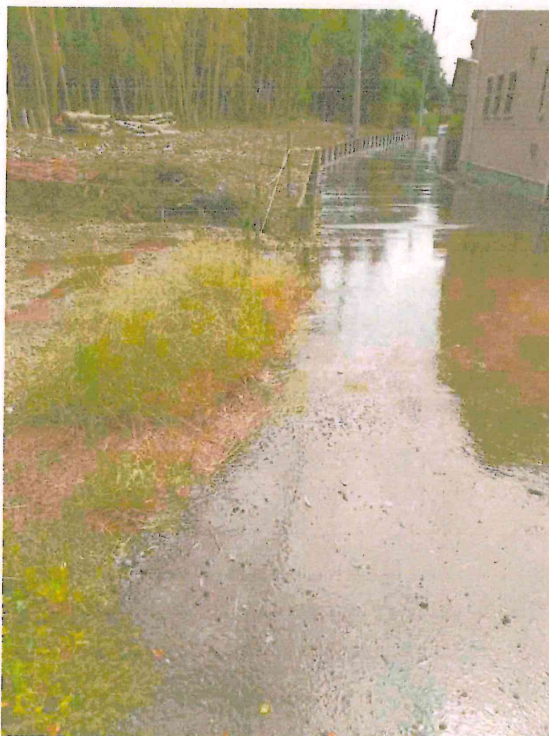
写真④: 9/21 大雨時に道路から流れ落ちた雨水であふれた住宅地(9/22 撮影)
