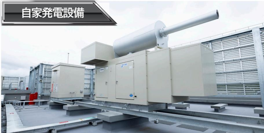
外部からの給油がなくても、新庁舎での業務が最大96時間継続できる電力供給が可能。
