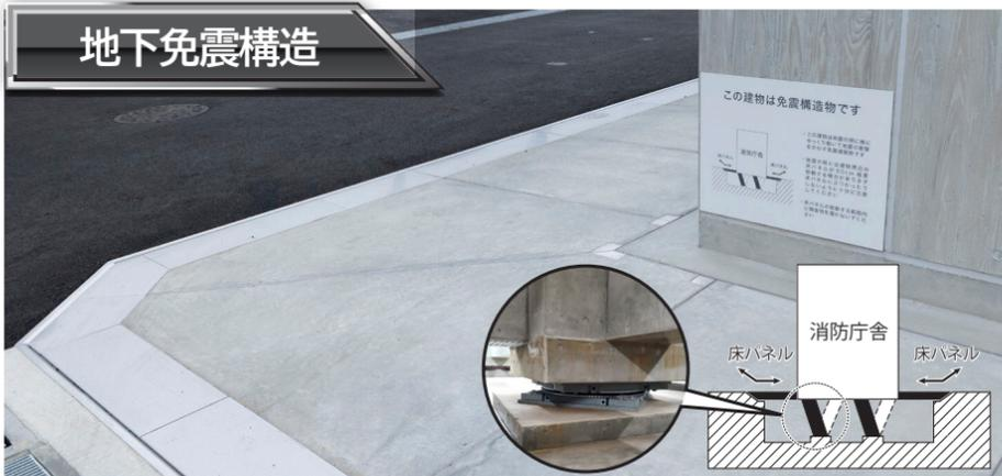
大規模地震発生時も防災拠点として機能を維持できるよう、床パネル部分がスライドし、揺れを軽減する地下免震構造を採用。
