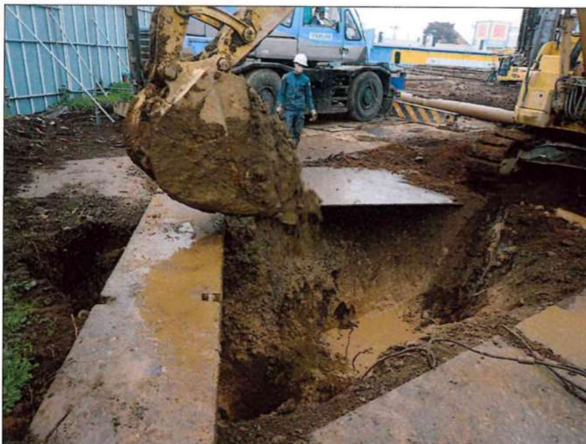
2号棟 杭抜工 山砂埋戻状況
