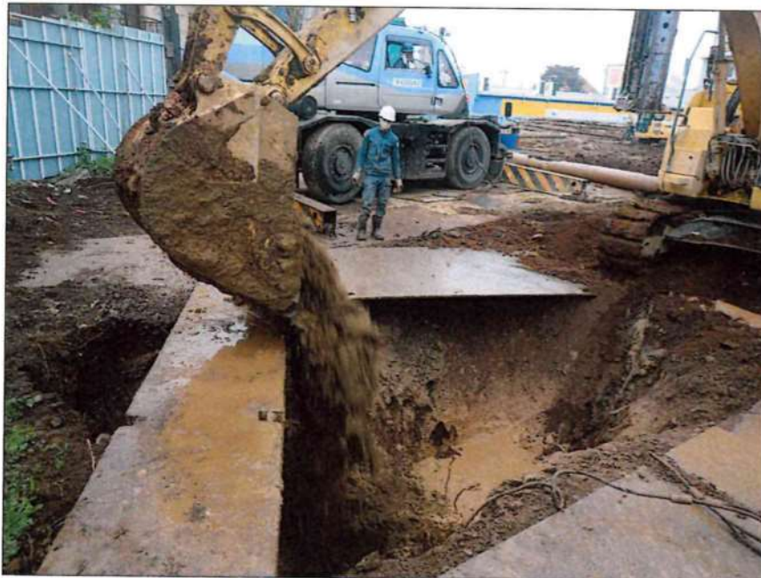
2号棟 杭抜工 山砂埋戻状況
