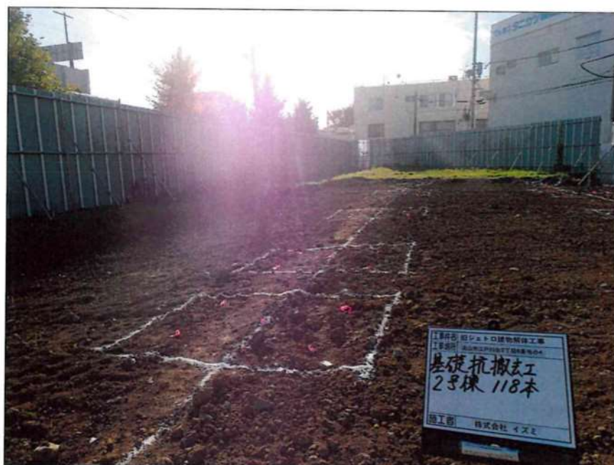
2号棟 杭抜工 杭施工前マーキング
