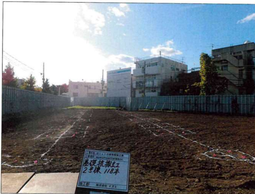
2号棟 杭抜工 杭施工前マーキング
