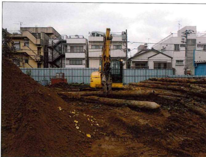
2号棟 杭抜工 杭切断状況
