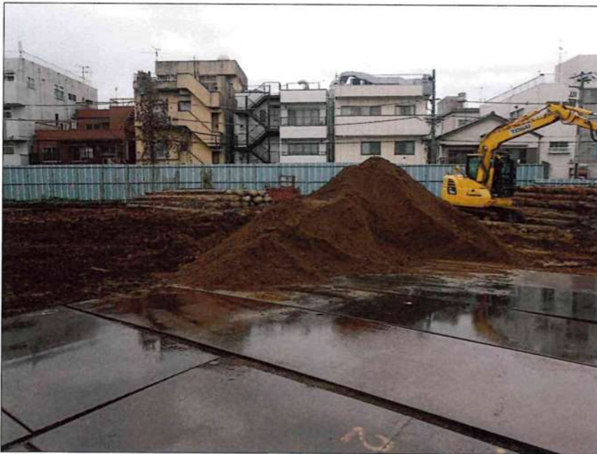
2号棟 杭抜工 山砂埋戻状況
