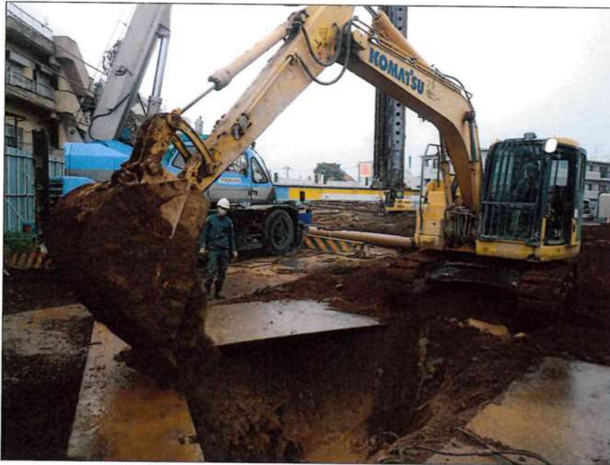
2号棟 杭抜工 山砂埋戻状況
