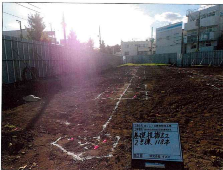
2号棟 杭抜工 杭施工前マーキング
