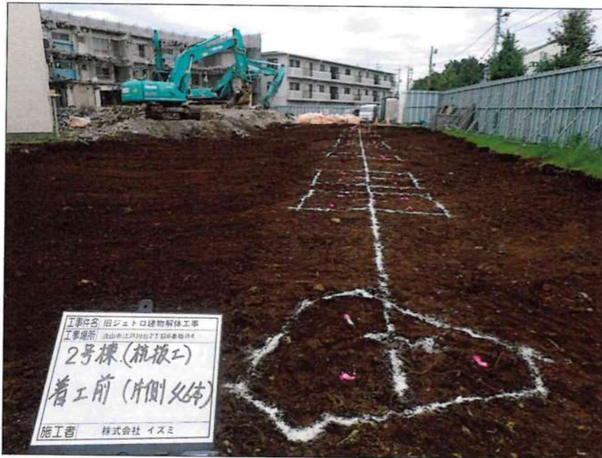
2号棟 杭抜工 杭施工前マーキング
