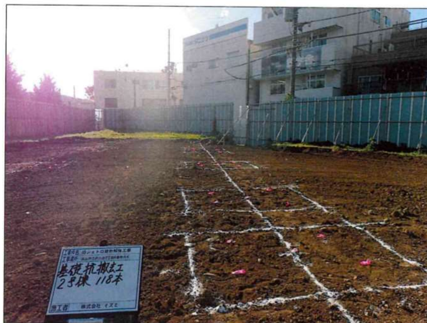
2号棟 杭抜工 杭施工前マーキング
