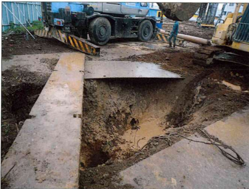
2号棟 杭抜工 山砂埋戻状況
