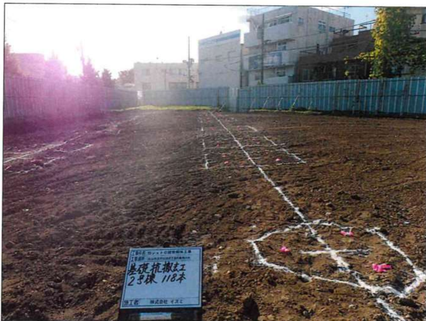
2号棟 杭抜工 杭施工前マーキング
