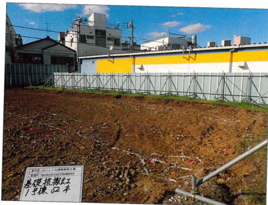
1号棟 杭抜工 杭施工前マーキング
