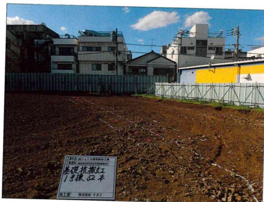
1号棟 杭抜工 杭施工前マーキング
