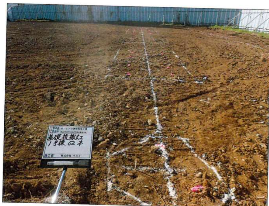
1号棟 杭抜工 杭施工前マーキング
