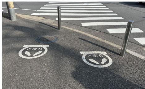
通学路合同点検で設置した車止めと足跡マーク
