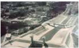
運河水門新設工事の様子
