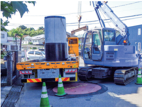
下水道整備の様子
