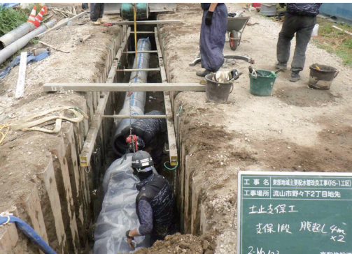
配水管の改修の様子
