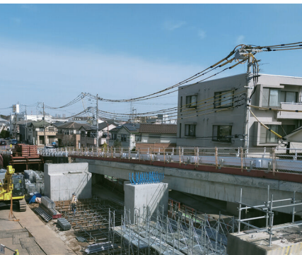
拡幅工事が進む名都借跨線橋
