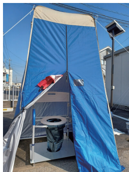
北部公民館のマンホールトイレ
