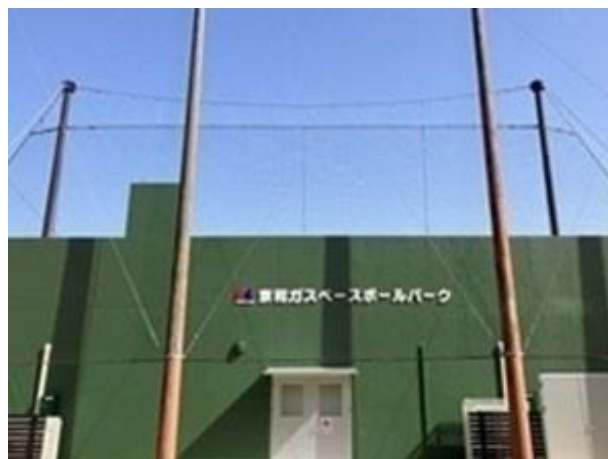
(京和ガスベースボールパーク)
