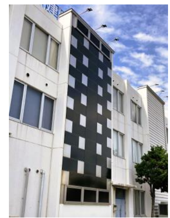
壁面設置型太陽光発電
