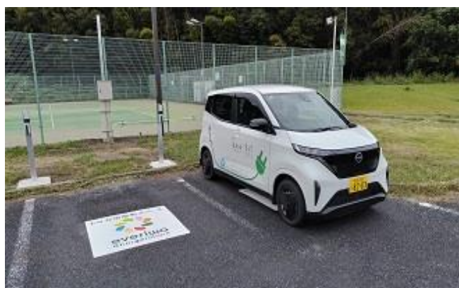
電気自動車及び充電設備 (コミュニティプラザ)
