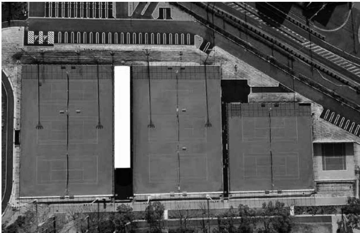
総合運動公園庭球場の再整備状況
