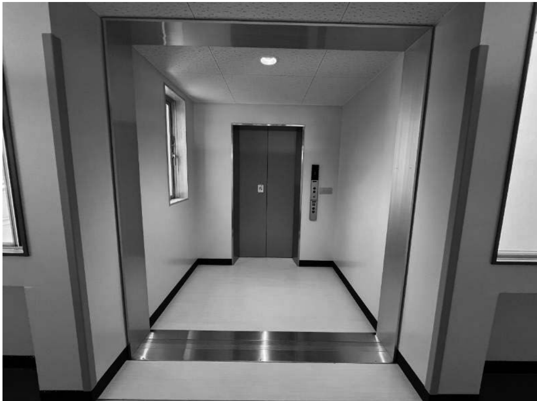
東深井中学校エレベーター増築工事
