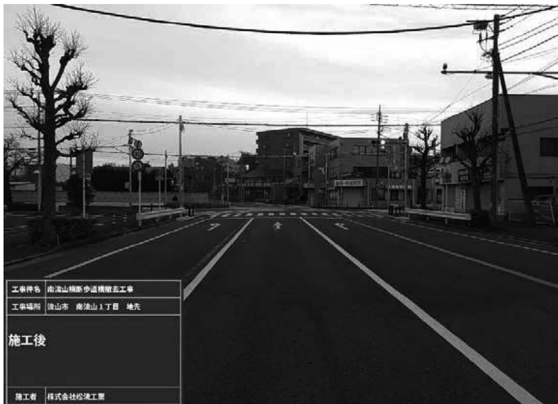
南流山横断歩道橋撤去工事：完成写真
