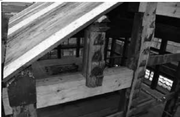
国登録有形文化財「秋元家住宅土蔵」保存修復工事
