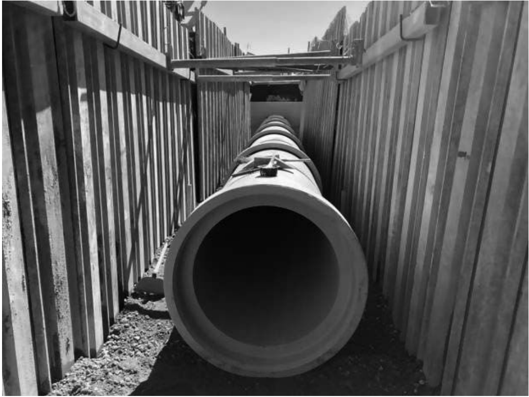
雨水排水管整備状況
