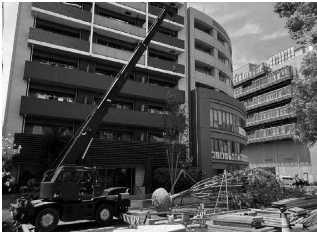
おおたかの森駅前センター地区道路（市道29024号線）の高木植栽状況
