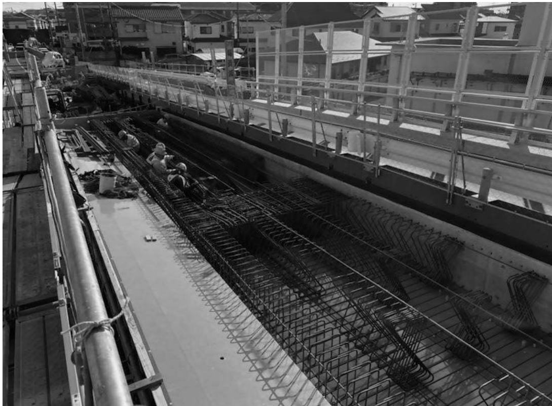
名都借跨線橋向小金2丁目南柏方の車道橋整備状況
