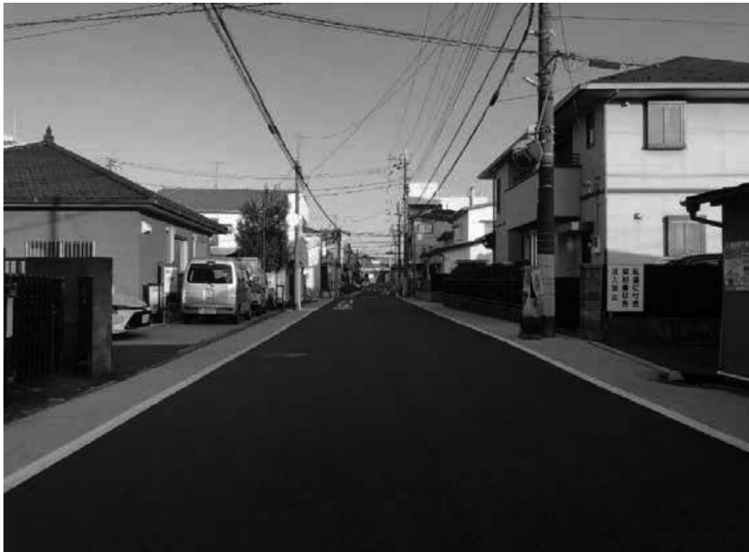
区画道路補修工事（流山1丁目）施工完成写真
