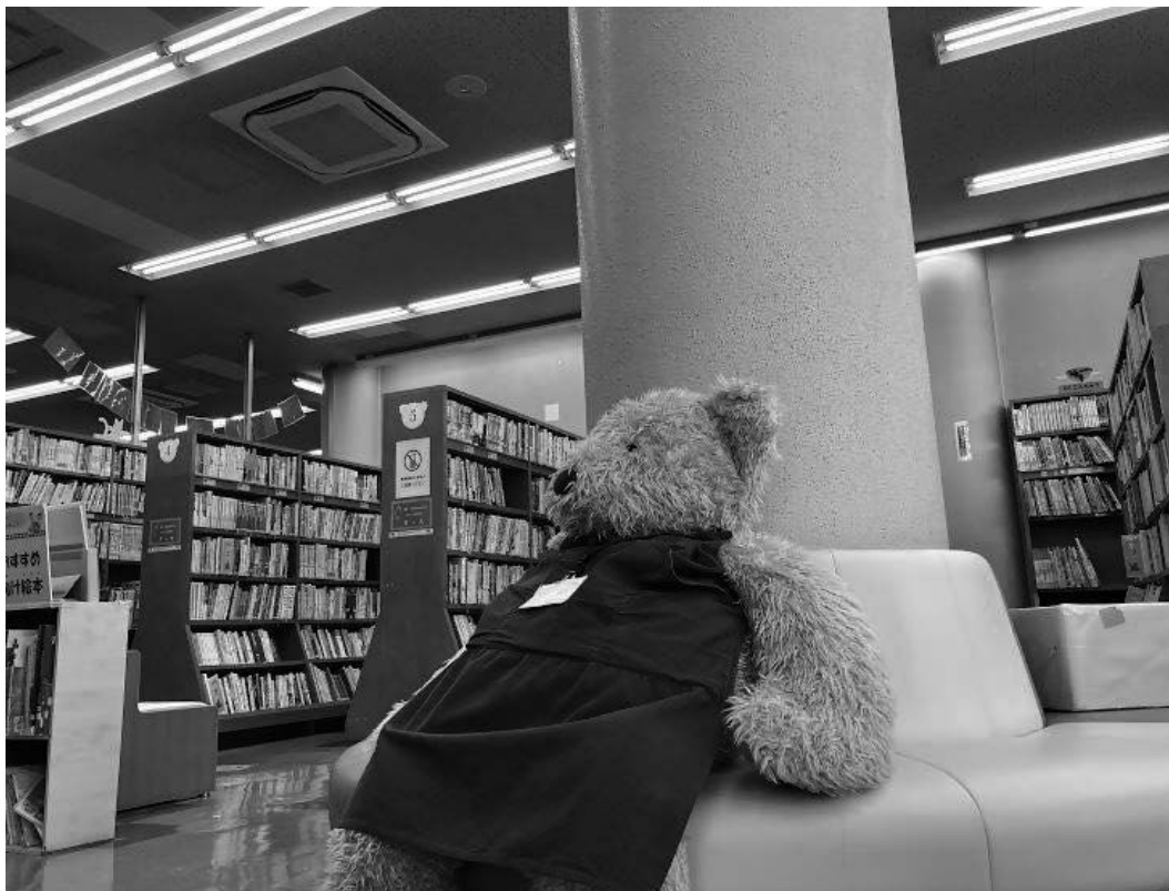
中央図書館の修繕した非常用照明（天井）
