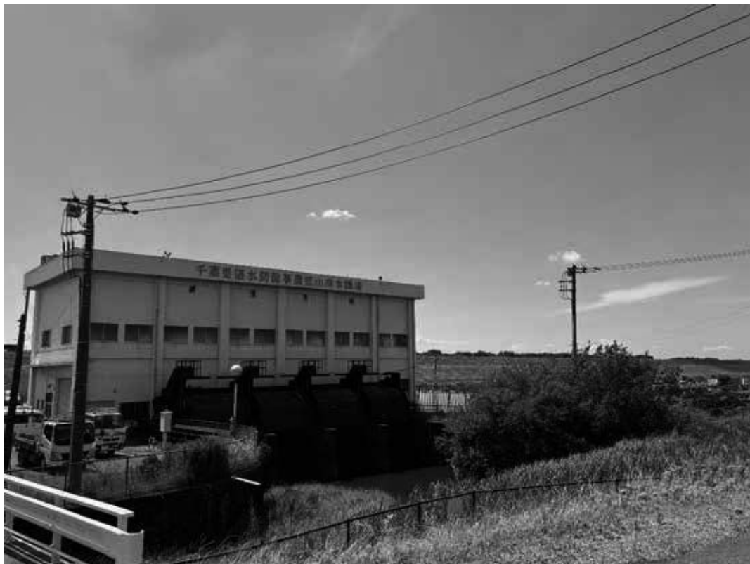
流山排水機場（予備電源状況）
