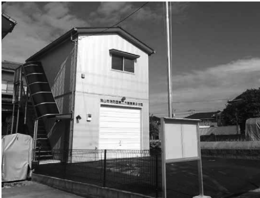
移転用地に建設した第8分団機械器具置場
