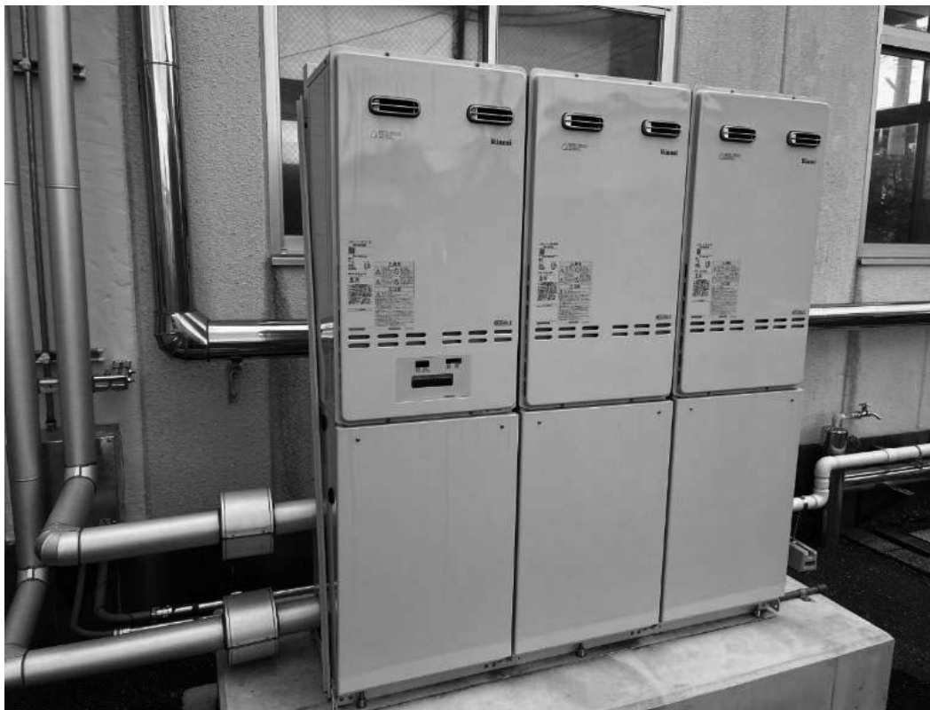
江戸川台小学校給湯器改修
