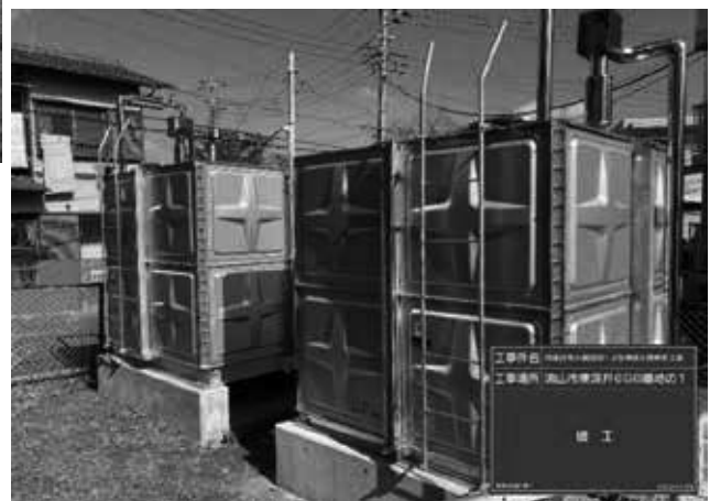
大橋団地1・2号棟受水槽更新
