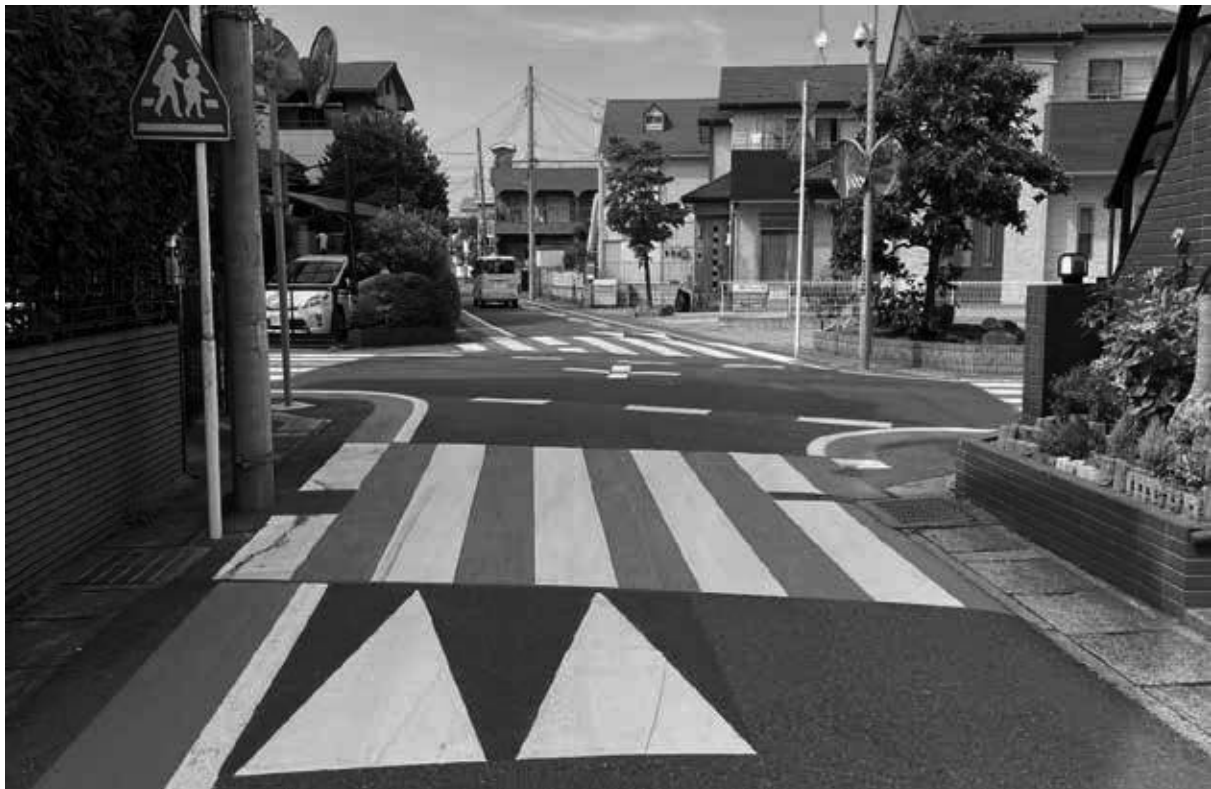
交通安全対策設置工事（鰯ヶ崎団地内）施工完成写真
