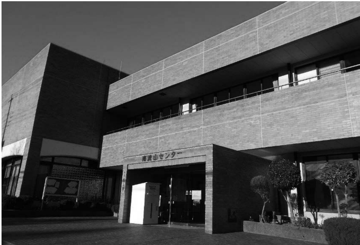
エレベーター更新工事を行う南流山センター
