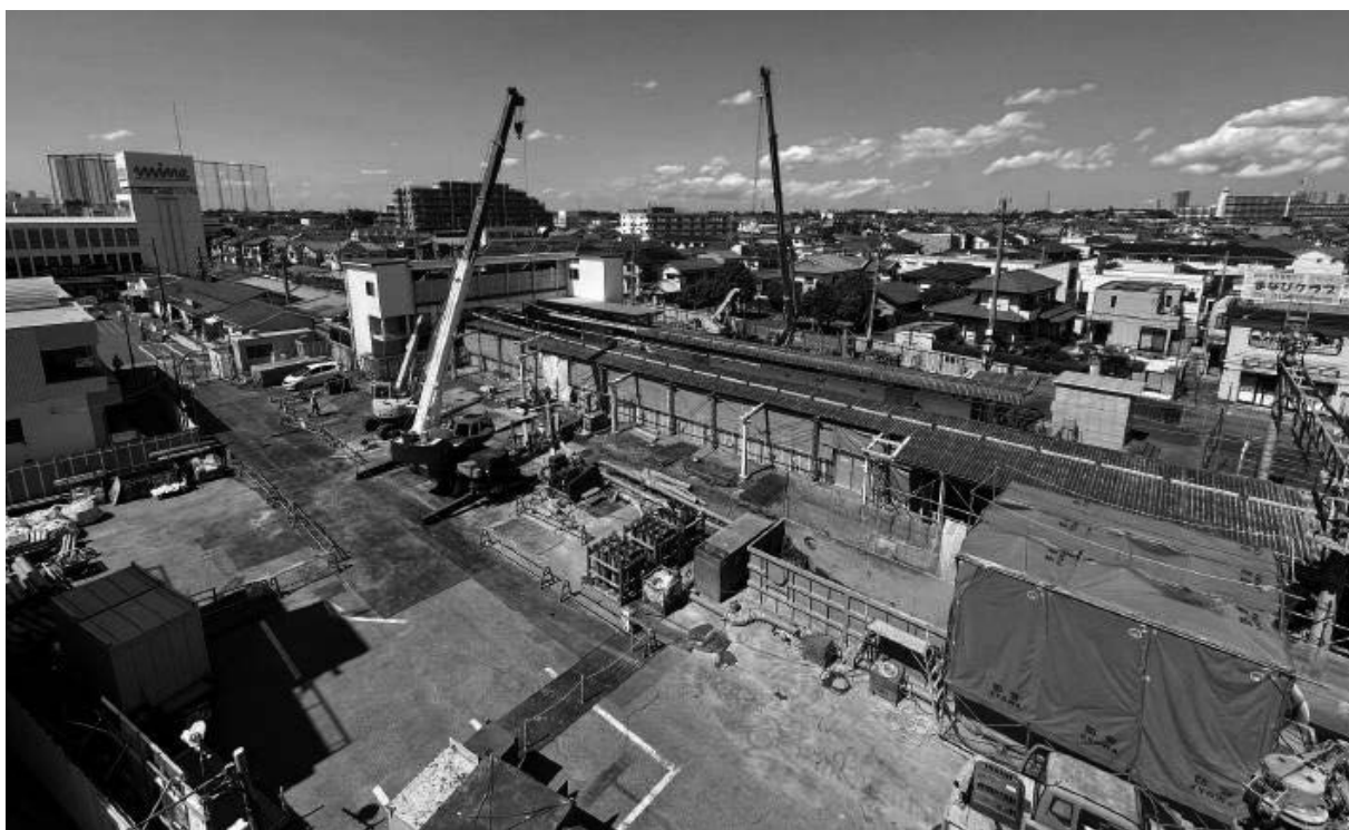
自由通路整備における杭工事（西口）
