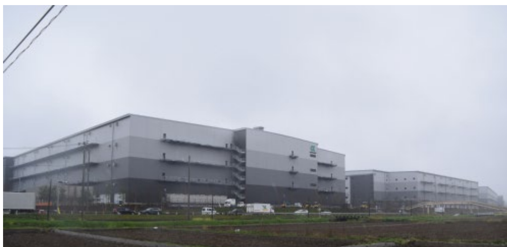
新川耕地に建てられた物流倉庫群
