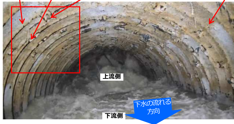
写真④ チュウ4MHから下流20～50m付近の状況（事故後に撮影・撮影日 2025/2/5）
