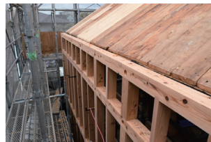
修復中の秋元家住宅土蔵の様子
