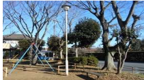
公園照明灯（設置例）
