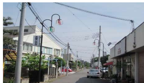
商店街街路灯（設置例）
