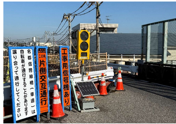
工事用信号による交通処理状況
