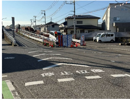
向小金1丁目側
