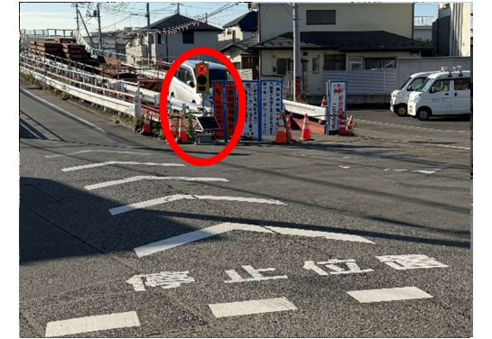
(※2)向小金1丁目側
