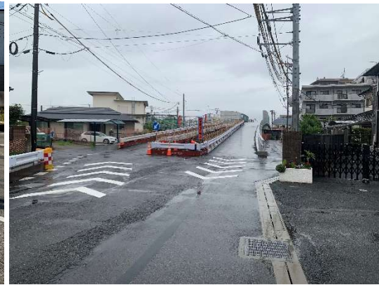
向小金2丁目側
