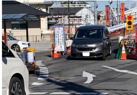
工事用信号による交通処理状況
