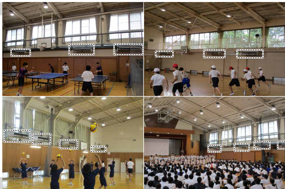
…設置したエアコン
