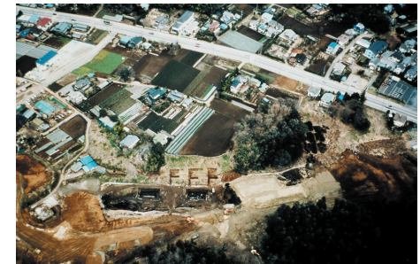
低地及び斜面部調査空撮(H7年)
