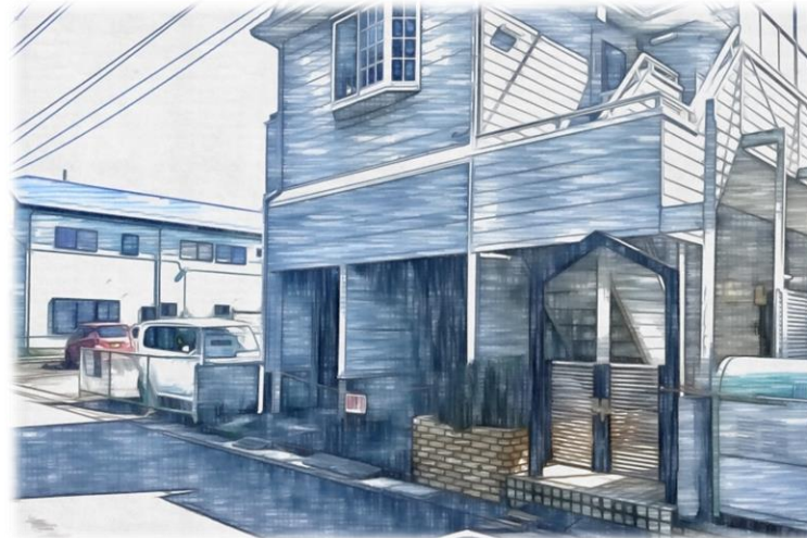
老朽化しつつある建物
