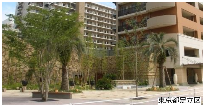
角地部分に広場を配置し、植栽を施している例
