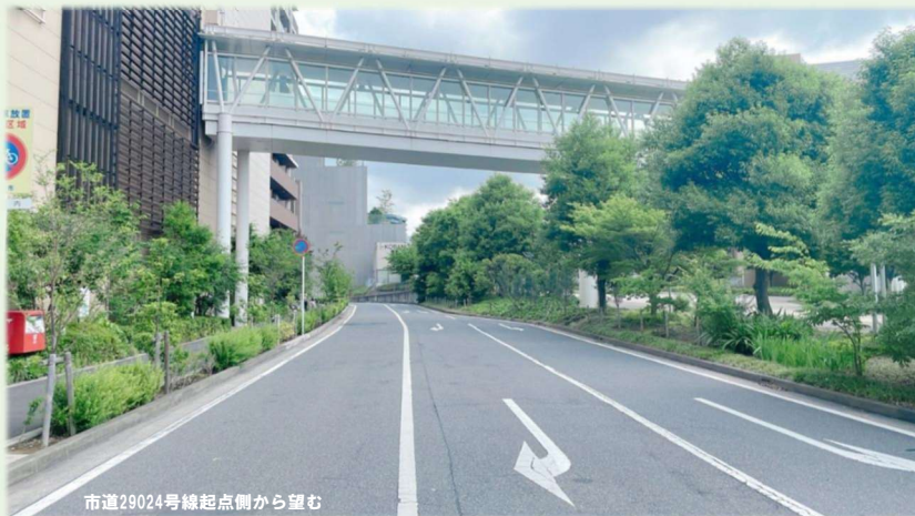
市道29024号線起点側から望む
