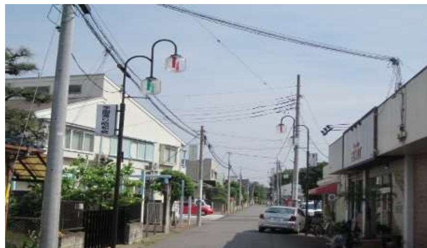
商店街街路灯（設置例）
