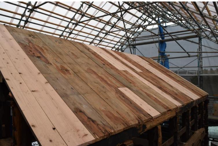
腐朽していた野地板を新しい材と交換する。
