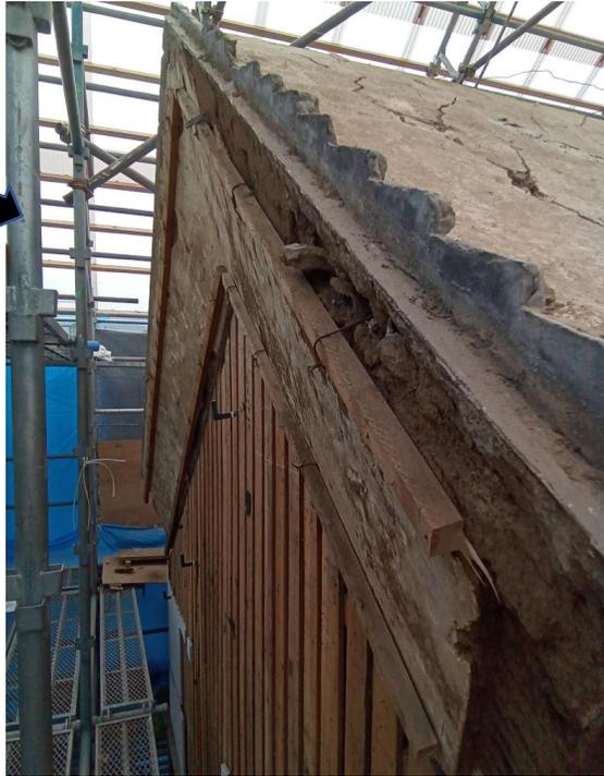
2階部分の壁を外すと、板材を確認。鉢巻と同じで、土壁ではなく、板材で壁厚を確保していたことがわかった。
