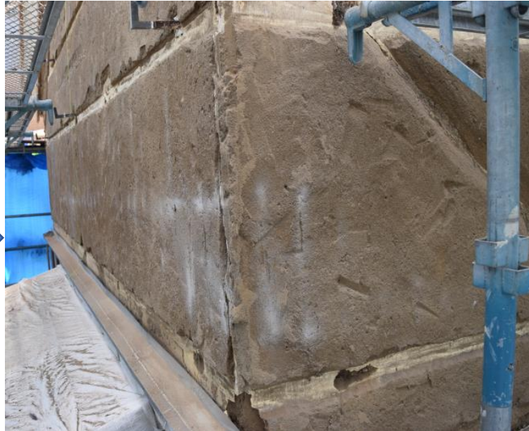
モルタル壁を除去し、中塗り層を確認
