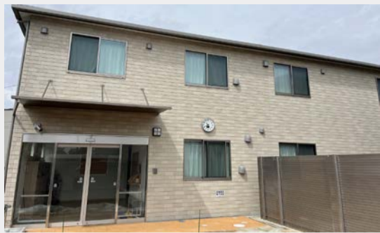
本日開設する保育施設
