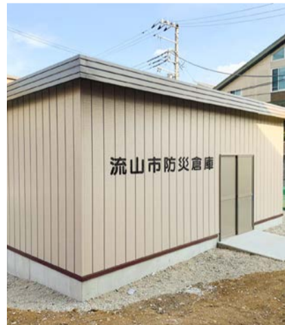
生涯学習センター(流山エルズ)の防災備蓄倉庫
