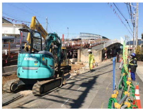
拡幅工事が進む名都借跨線橋
