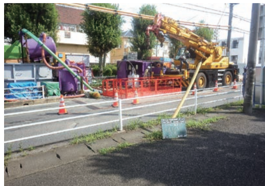
下水道を整備している様子
