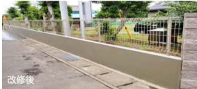
コンクリートブロック塀の改修例
