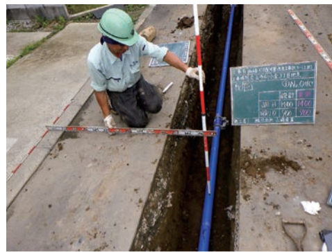
配水管の改修
