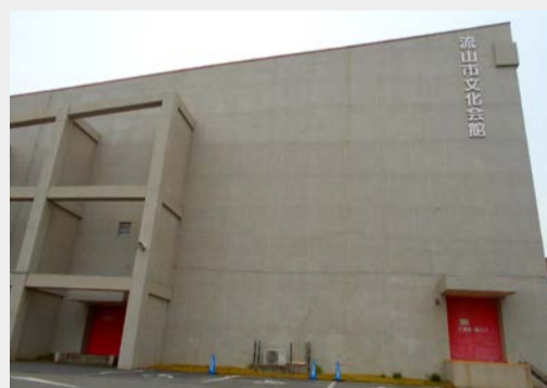
改修予定の文化会館の外壁
