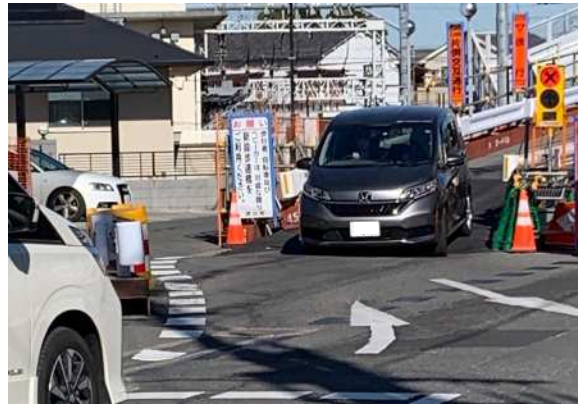
工事用信号による交通処理状況
