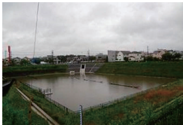
図 3-2-3 大雨時と平常時の新東谷調整池
