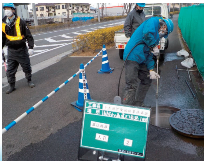
流山上下水道センターによる作業状況
