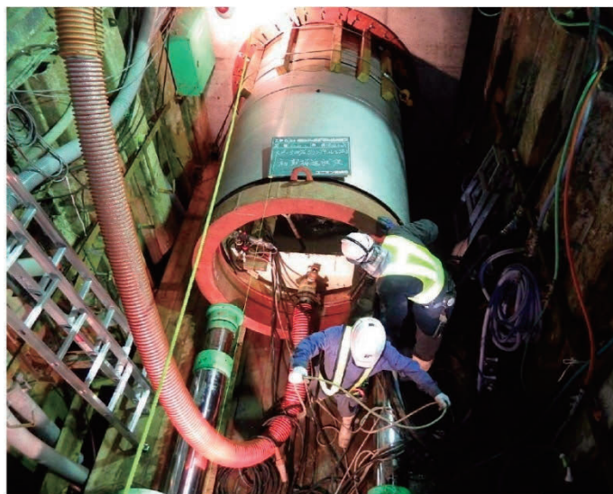
図 3-2-4 向小金雨水幹線の整備状況
