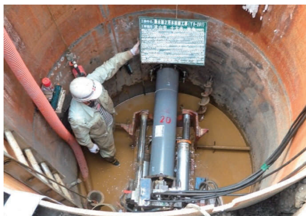
汚水管渠整備
