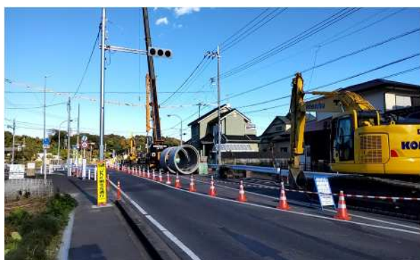
雨水管布設工事の様子
