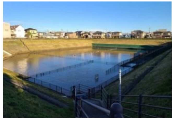
新東谷調整池
