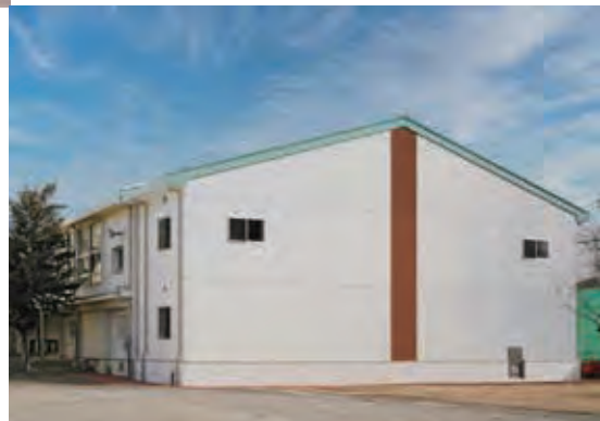
屋内運動場（体育館）増築 左：内部 右：外部
