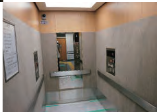
エレベーター改修工事の状況と完成後
