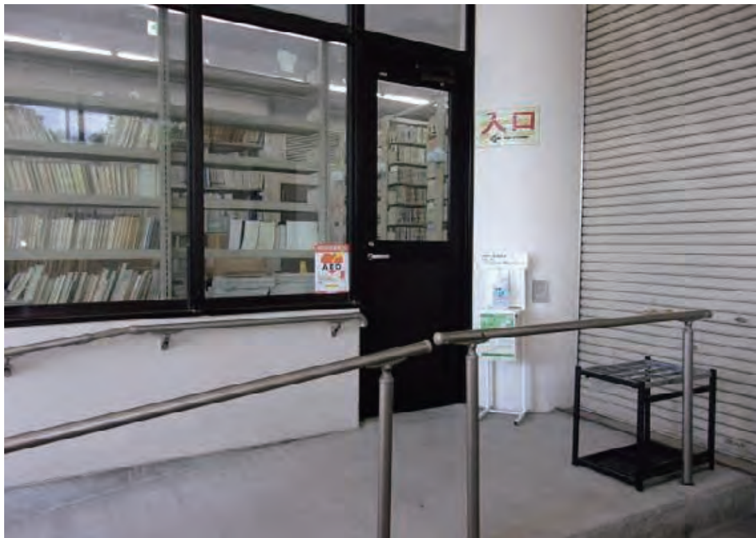
改修した図書館利用者用出入口
