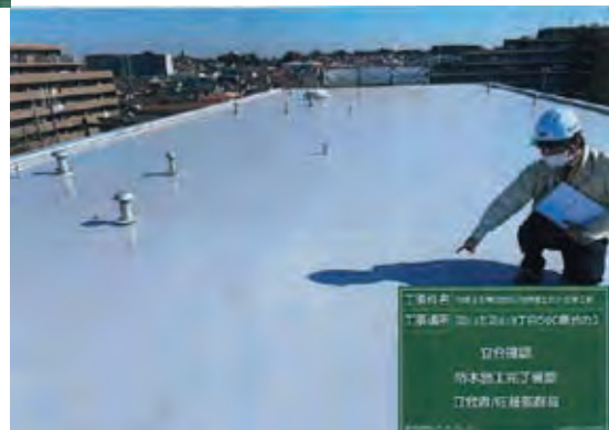
柳田団地2号棟屋上防水改修工事
