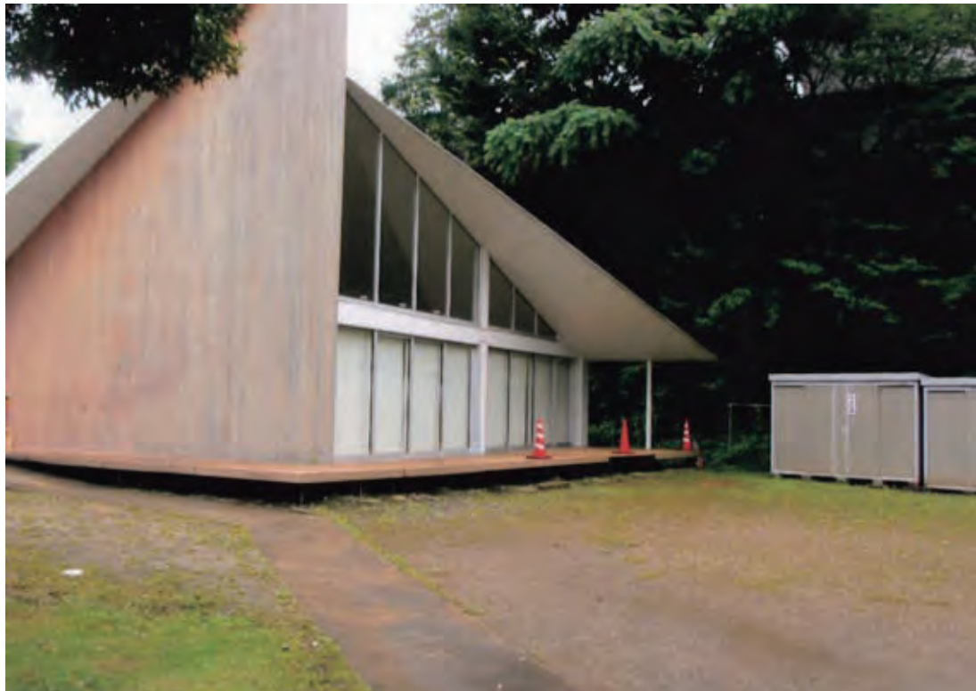
前ヶ崎みどり自治会館の外壁塗装修繕
