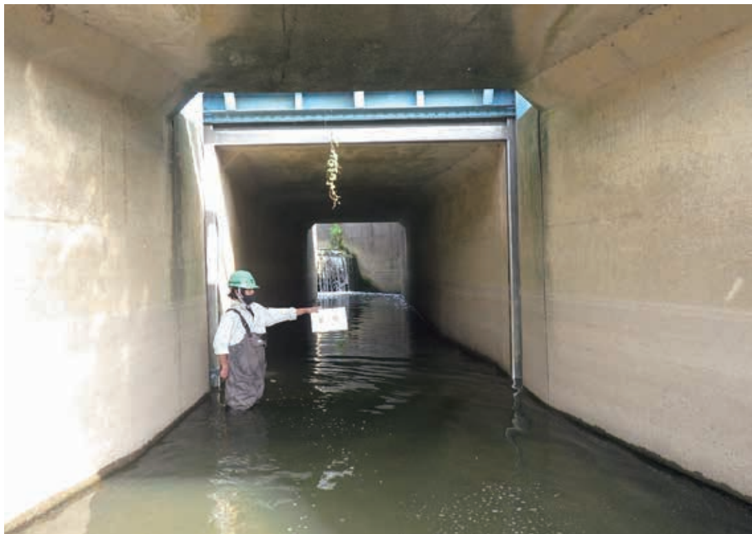
樋管点検状況
