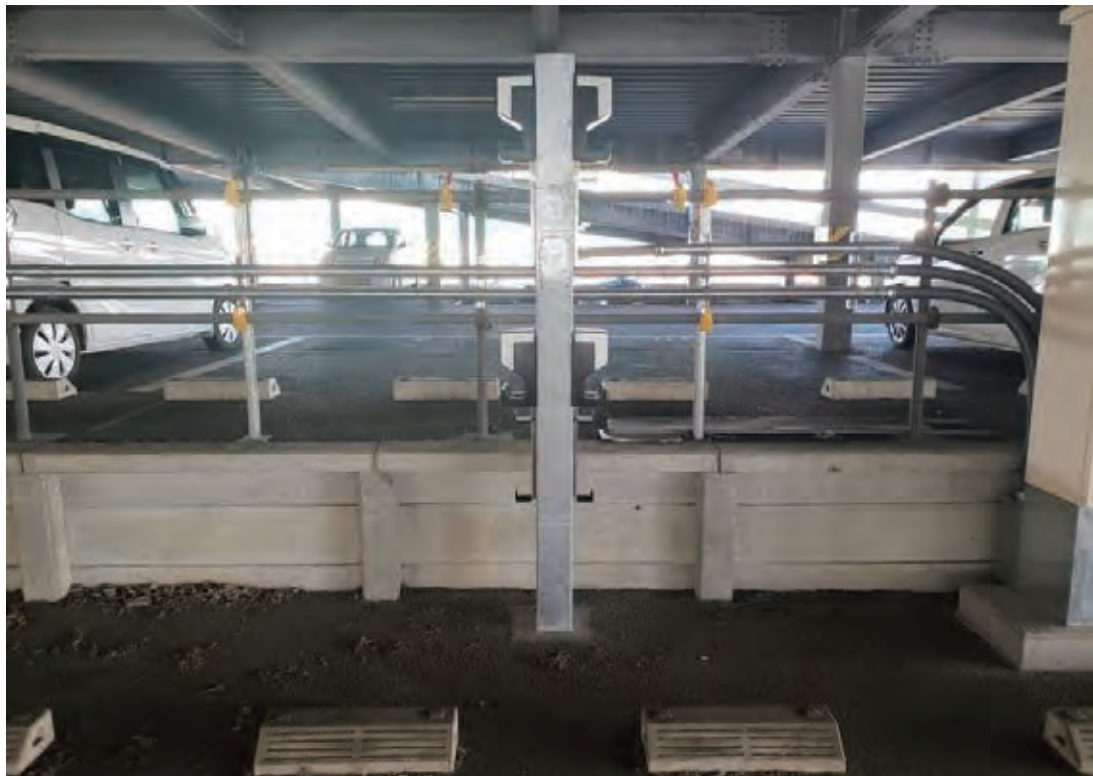
EV充電スポット（36台分整備）
