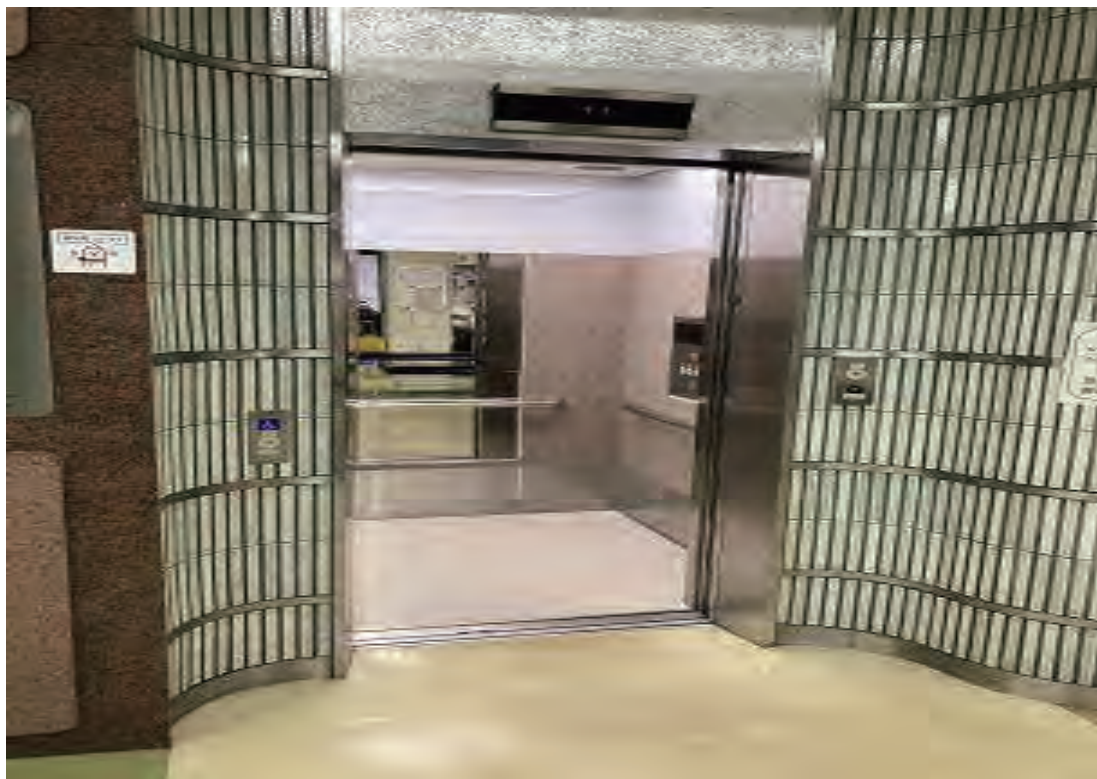
更新後のエレベーター
