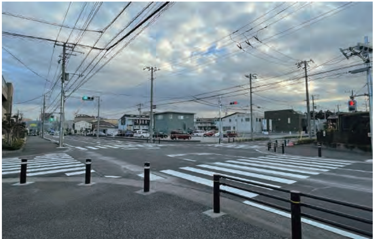
交通安全を確保するために設置したポールや防護柵
