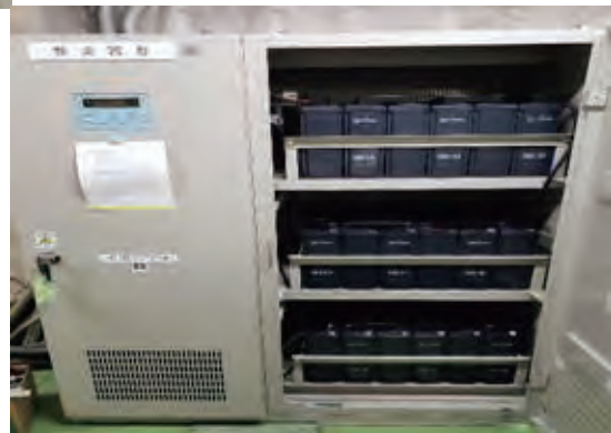
左：受変電設備改修 右：蓄電池設備改修
