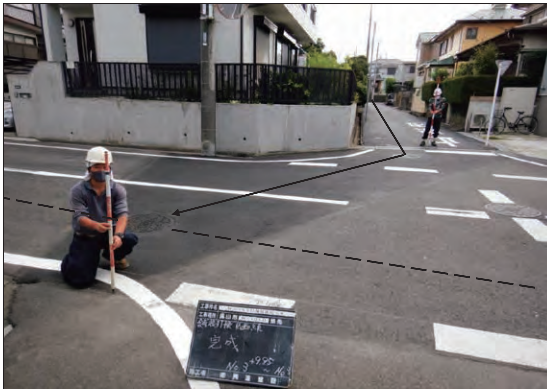
野々下5丁目地先雨水排水施設整備完成（黒実線部）
