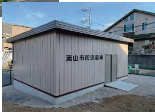
左：十太夫近隣公園の防災施設一式 右：生涯学習センターに設置した防災備蓄倉庫
