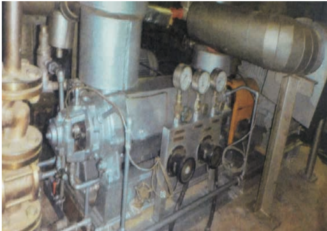
ごみ焼却施設 ボイラー給水ポンプ定期点検整備
