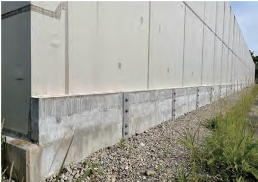
指定廃棄物一時保管施設 浸水対策工事
