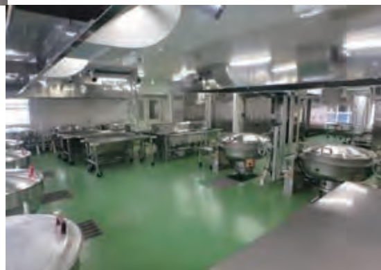
左：エアコン設置を完了した調理場（八木中学校） 右：調理場の増築（八木北小学校）
