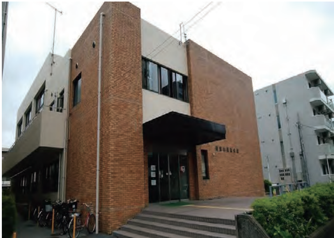
南流山福祉会館外壁改修工事
