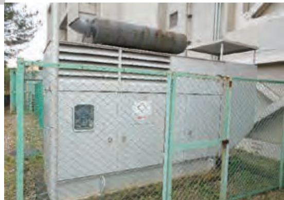
左：文化会館 右：文化会館非常用発電装置
