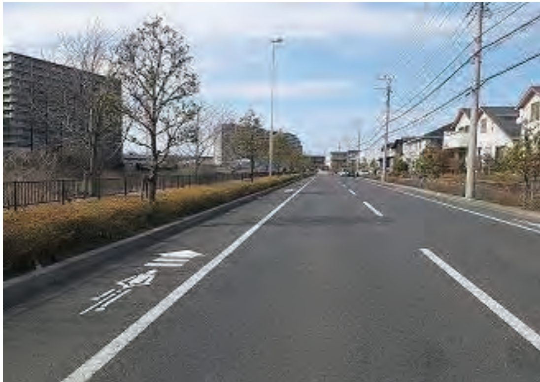
自転車通行空間を一部整備した都市計画道路3・4・8号美田駒木線
