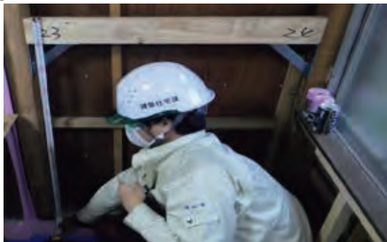
耐震改修工事の中間検査の様子
