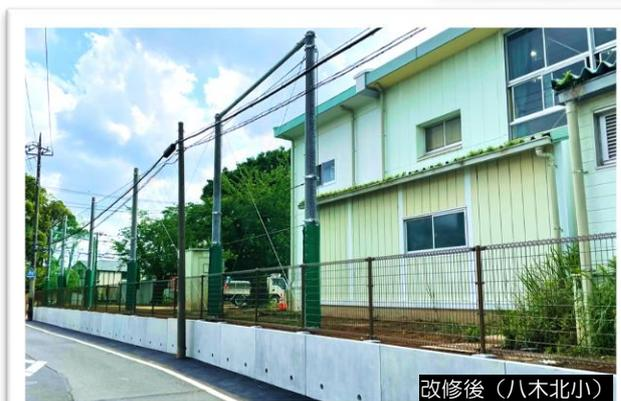
擁壁が傾いたため、安全対策として、フェンスと擁壁を交換しました。
