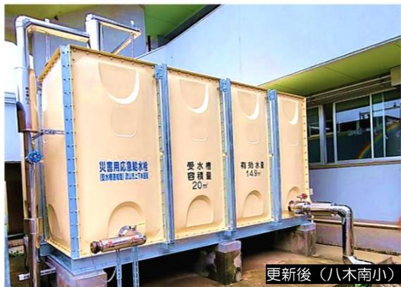
老朽化と漏水の改善のため、受水槽と給水管を交換しました。
