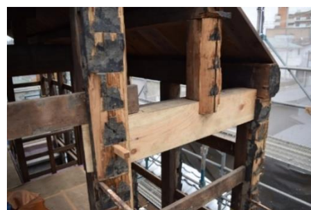
新しい梁に入れ替える
