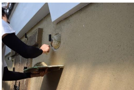
職人による土壁塗り
