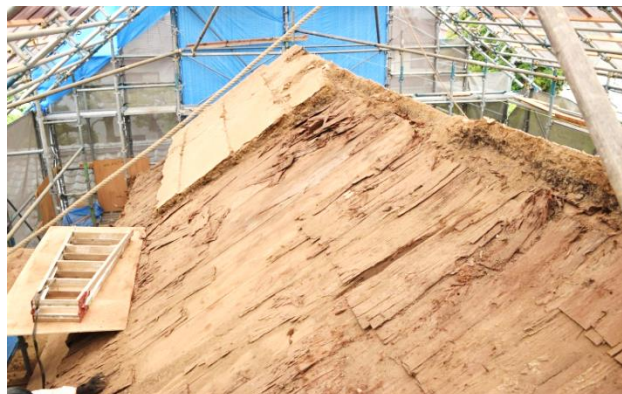
解体中の屋根。杉皮が見える。
