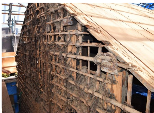
解体中の壁。格子状に組まれた竹が見える。
