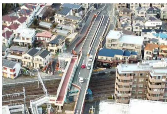
拡幅工事の進む名都借跨線橋
