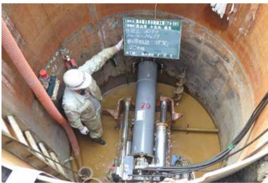
下水道の整備
