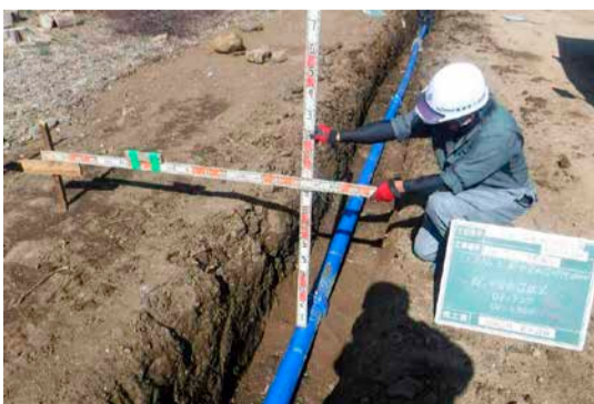
配水管の改修
