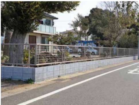
改修されたコンクリートブロック塀
