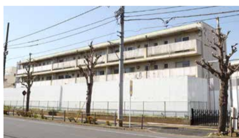
解体する旧JETRO職員住宅跡
