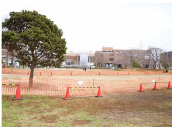
西初石近隣公園(おたかの森駅南口公園)の広場の整備
