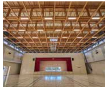
屋根を支えるはりに国産木材を活用した、木質大空間の体育館
