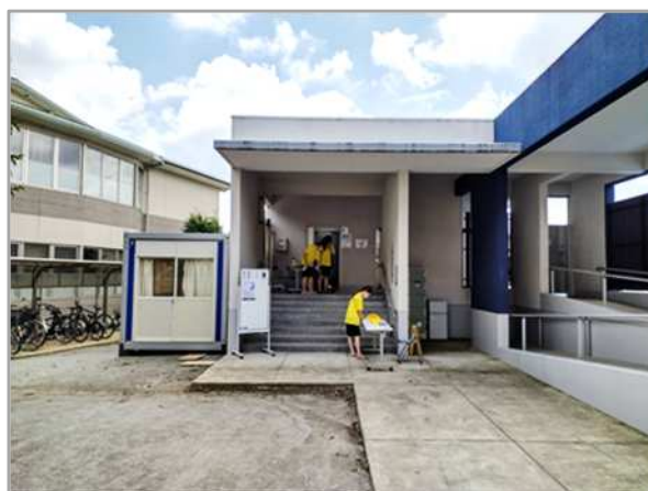
プール正面入口
