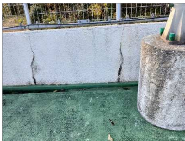
壁面老朽箇所
