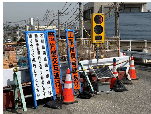
工事用信号による交通処理状況
