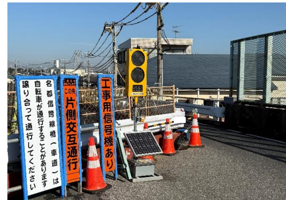
工事用信号による交通処理状況
