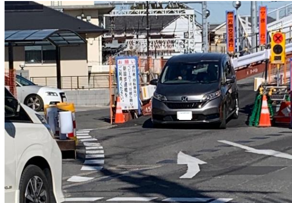
工事用信号による交通処理状況
