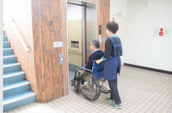
エレベーター設備を更新して使いやすくなった初石公民館
