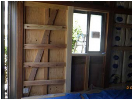
耐震改修例 耐力壁を新設（左側）、 大きな窓を小さな窓に変更（右側）
