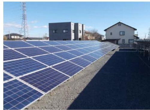
太陽光パネル
