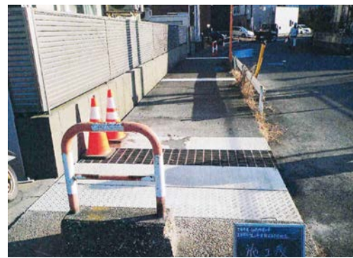
昨年度補修を行った水路
