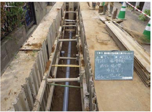
下水道工事の様子
