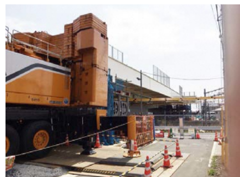
拡幅工事の進む名都借跨線橋
