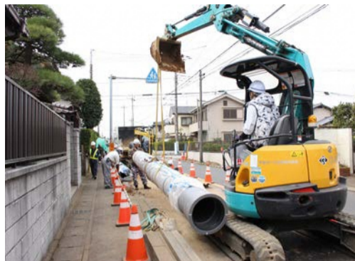
耐震管敷設工事の様子
