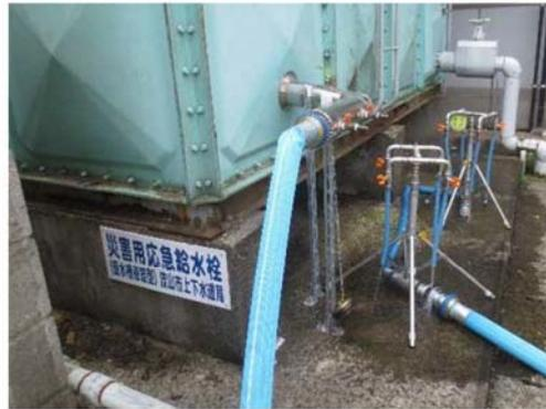
図 3 小学校の受水槽に設置した応急給水栓
