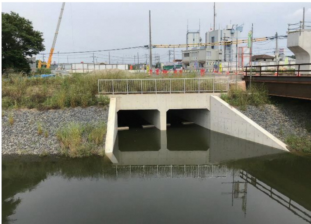
和田堀都市下水路新樋管
