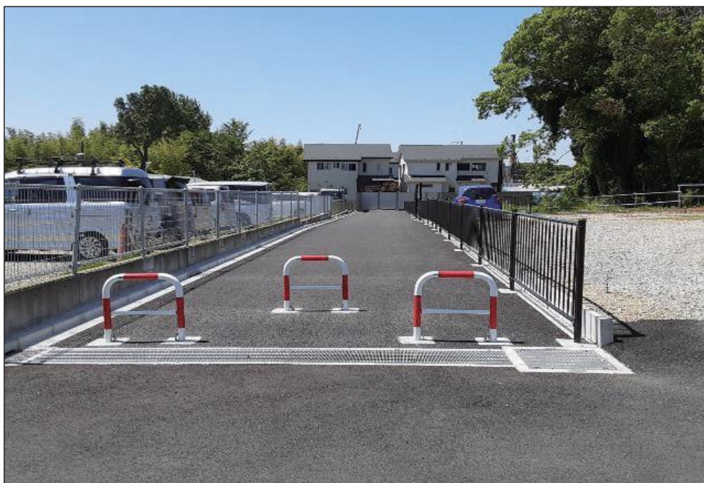
新設小学校建設関連道路整備事業工事
