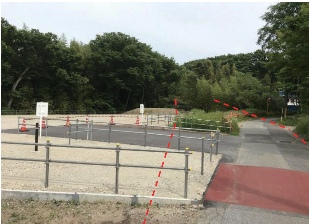
新設小学校建設に伴う道路計画地(雨水排水施設整備予定地)
