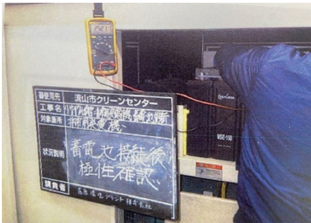
リサイクル館無停電電源装置整備
