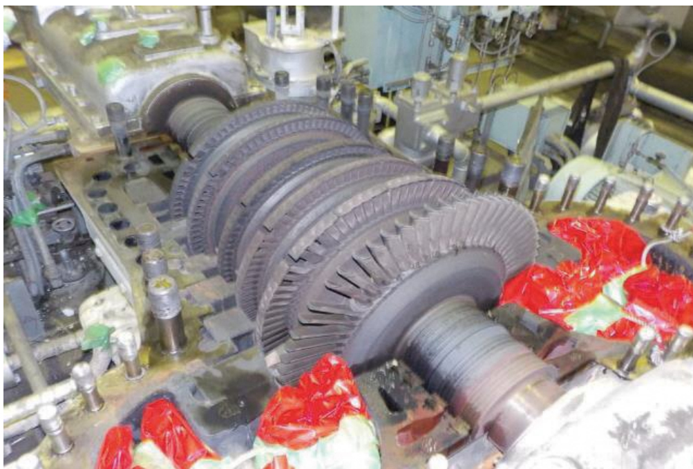
蒸気タービン定期整備
