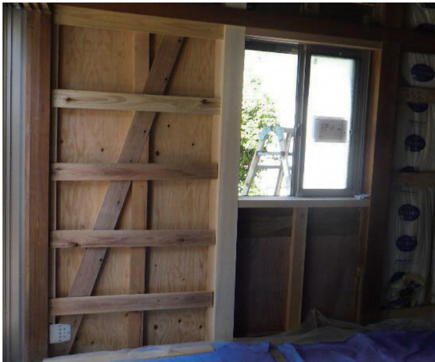
耐震改修工事の施工状況 (小さい窓に変更し、耐力壁を設置)
