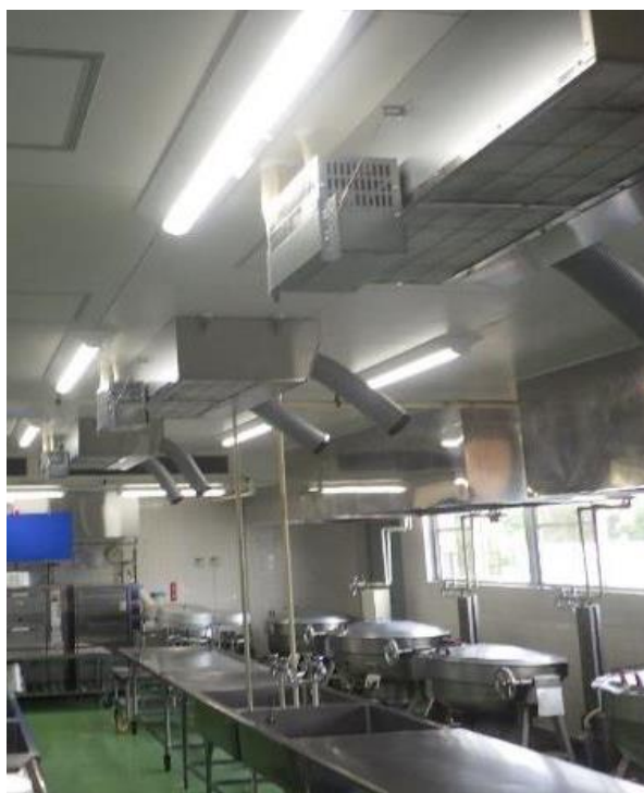
調理室エアコン設置状況の写真
