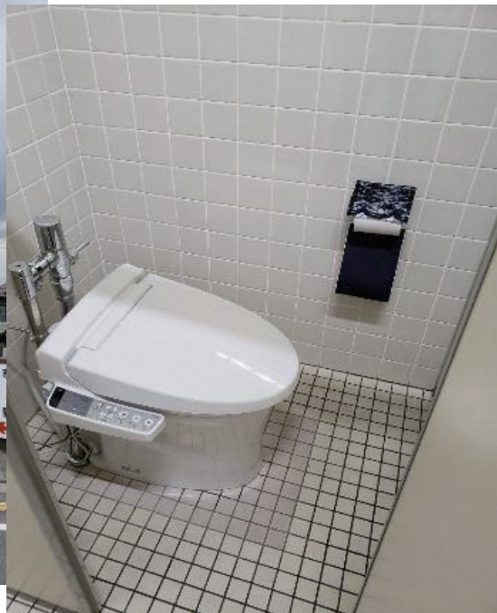
トイレ改修工事
