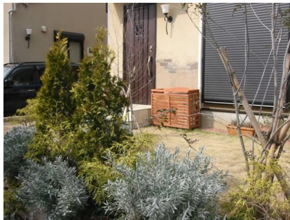
エアコンの室外機を、木製のパネルで囲い込み、目立たなくなる工夫をする。
