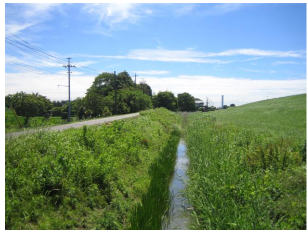
農村風景と調和した水路の修景を行います。
