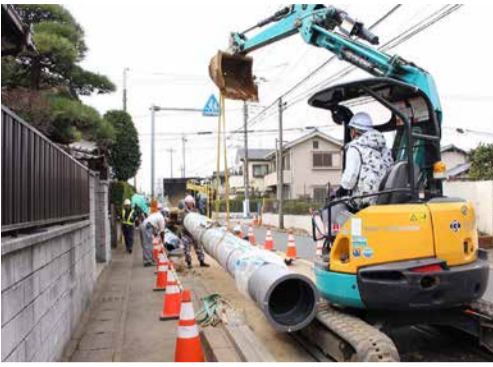
耐震管敷設工事の様子
