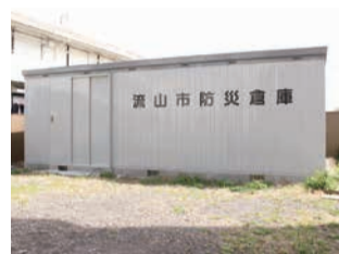
昨年度整備された防災備蓄倉庫設
