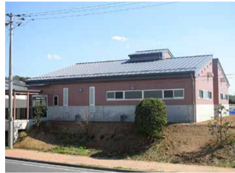
昨年度浴室増築を行い、今年度オープンを予定しているほっとプラザ下花輪(下花輪福祉会館)
