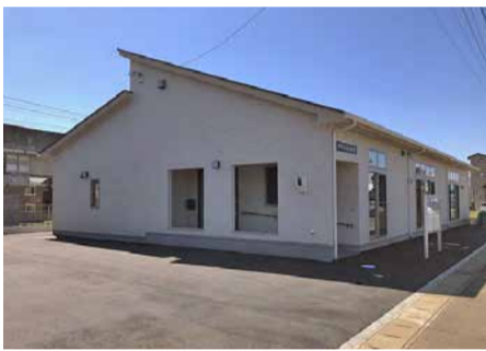
昨年度整備された自治会館 の冷暖房機器設置や大規模修繕に補助金を交付します。
