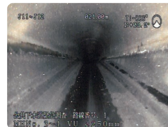
▲下水道管内部の様子
