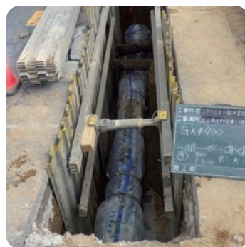
▲配水管布設が完了した様子
