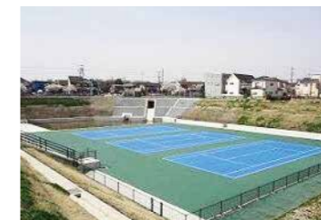
▲平常時はテニスコートとして使用している新東谷調整池
