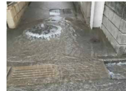
▲雨水があふれる污水ます
