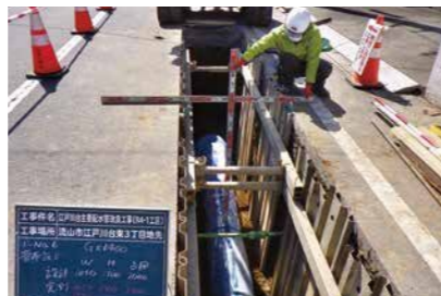
▲水道管改良工事のようす
