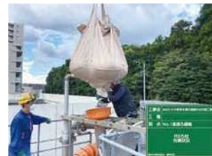
▲おおたかの森浄水場のろ過機ろ材交換の様子
